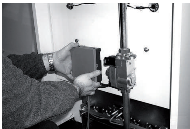
рис. 8 - Снимите блок управления
