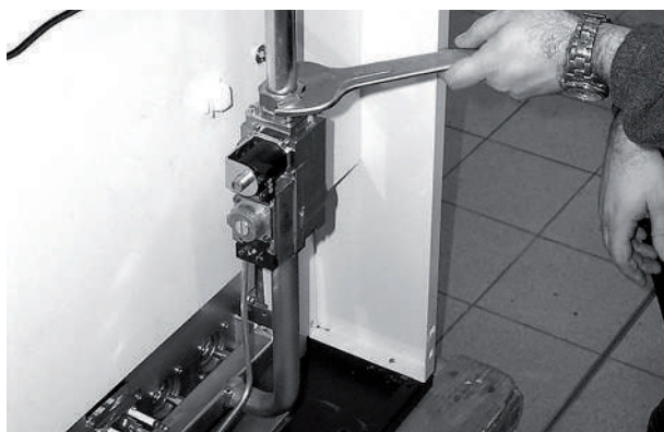
рис. 9 - Открутите гайку крепления газового клапана
